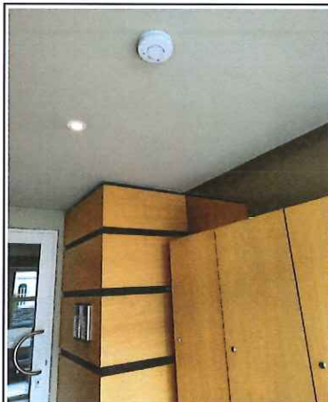
Foto 2: Rookmelder inkom waar de technische installaties zich bevinden
